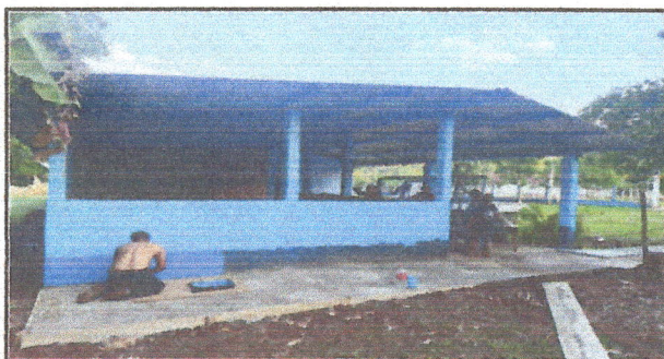
Foto 5: se observa la estructura de techo de metal galvanizado, la colocacion de laminas troqueladas y el retoque de pintura en las paredes
