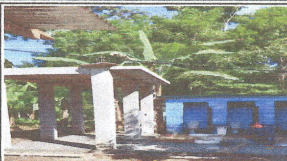
Foto 2: vista de modulo de baños y del area de la base para el deposito de agua
