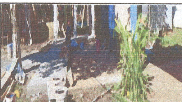
Foto 6: se observa la reparacion de la losa del patio y la base del tinaco
