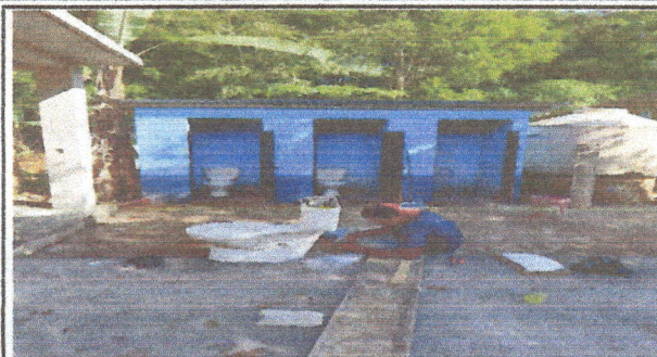
Foto 1: Se observa la instalación de nuevas tazas sanitarias
