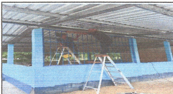
Foto 3: se observa el trabajo de instalacion de ventanas y balcones
